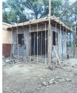
Foto 2: laboratorio en construcción
