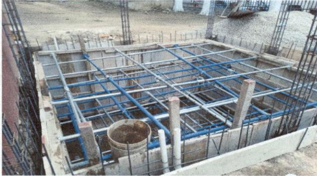
Foto1: cisterna fundida de 4 paredes de 12 cm de ancho.
