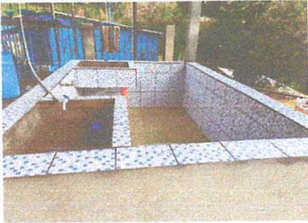
Foto 1: nueva pila ya terminada de construir.
