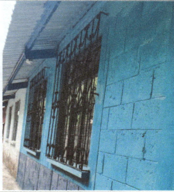
Foto 1: Corredizos 80x80 ventanales existentes.
