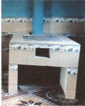
Foto 1: Construcción de pollo chimenea de tubo concreto de 4 medidas 140 largo x 90 ancho x 85 alto con plancha y azulejo
