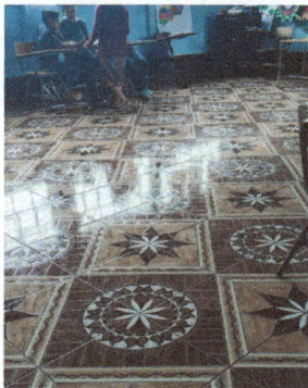
Foto 5: Colocación de piso en aula 1.
