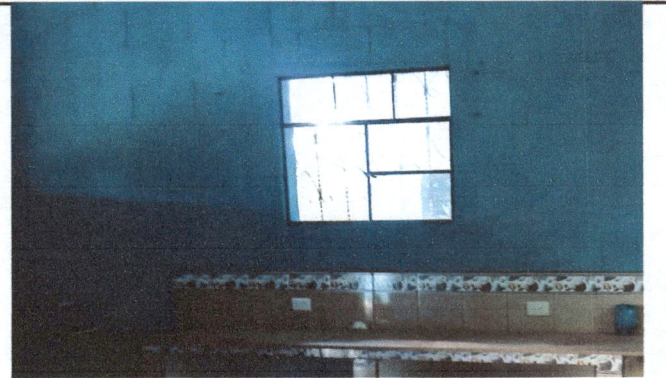
Foto 4: Abertura de pared para ventana de 1 x 80 cms.
