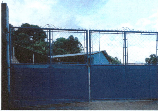
Foto 1: Remodelación a porton existente con lámina de perfil más pintura en la mitad parte de abajo.
