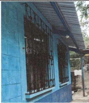
Foto 5: Cambio de vidrio de ventana.
