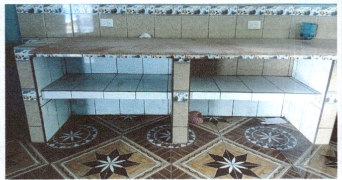
Foto 2: Construcción de Gabinete de concreto mas azulejo exterior de dos espacios 2.50 x 60 de fondo x 85 de alto.
