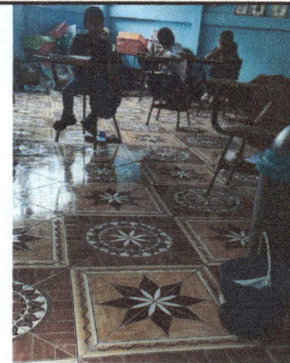
Foto 6: Colocación de piso en aula 2.
