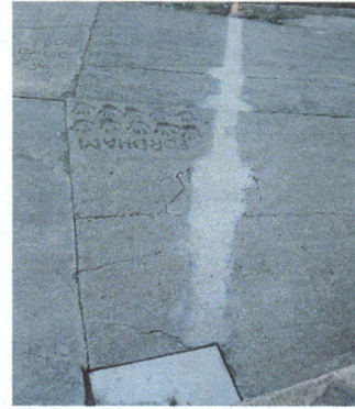
Foto 2: Romper torta e instalación de tubería salida de agua en la entrada de la escuela.
