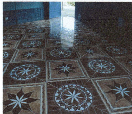
Foto 4: Colocación de piso 43x43.
