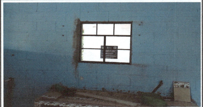
Foto 4: Abertura de pared para ventana de 1 x 80 cms.
