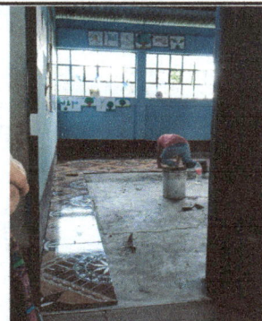
Foto 6: Resanar para nivelar torta existente en aula 2.
