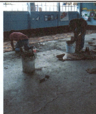
Foto 4: Colocación de piso 43x43.
