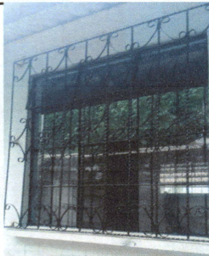
Foto 1: Corredizos 80x80 ventanales existentes.
