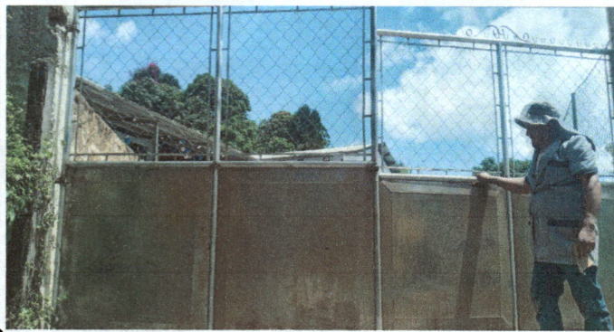
Foto 1: Remodelación a porton existente con lámina de perfil más pintura en la mitad parte de abajo.
