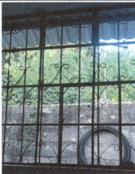
Foto 5: Cambio de vidrio de ventana.
