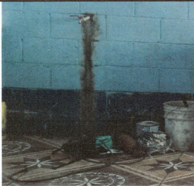
Foto 3: Instalación de una pila, más instalación de agua y salida de drenaje.
