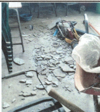
Foto 5: Resanar para nivelar torta existente en aula 1.
