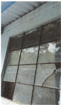
Foto 5: Cambio de vidrio de ventana
