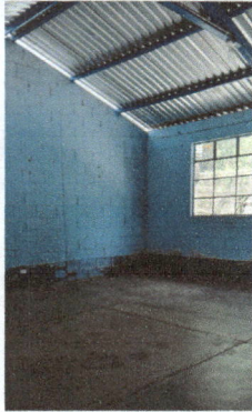
Foto 1: Construcción pollo chimenea de tubo concreto de 4 medidas 140 largo x 90 ancho x 85 alto con plancha y azulejo
