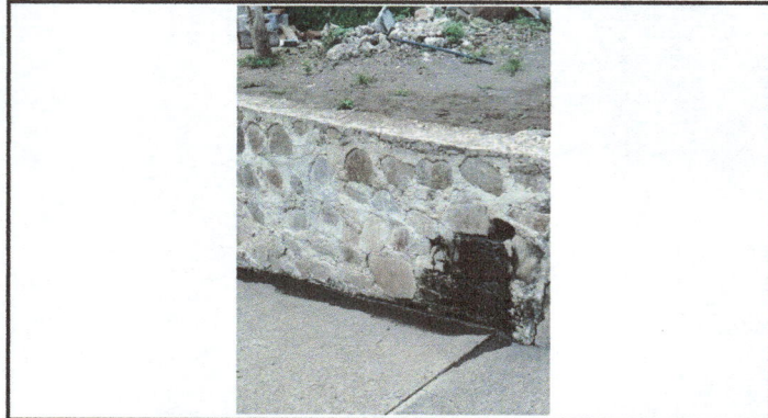
Foto 2: Romper torta e instalación de tubería salida de agua en la entrada de la escuela.
