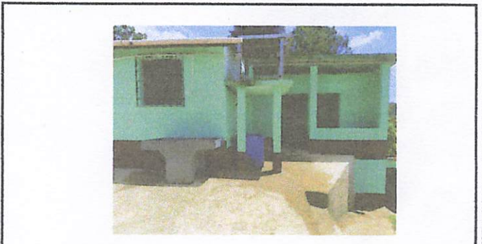
Foto 6: Colocación de base metálica para subir el depósito de agua.
