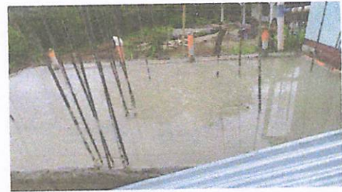
Foto 4: Se vertió el cemento o terraza.
