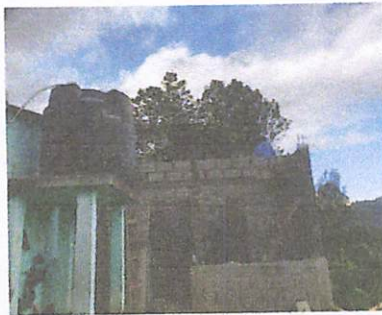
Foto 5: Levantado de paredes para los sanitarios.
