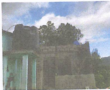
Foto 5: Levantado de paredes para los sanitarios.
