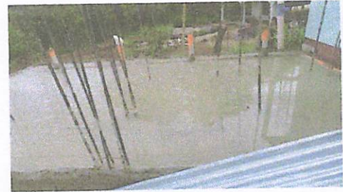
Foto 4: Se vertió el cemento o terraza.
