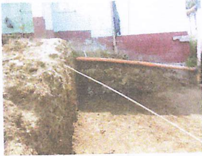
Foto1: Se preparó el espacio para que se iniciara el trabajo.
