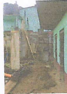
Foto 2: Aquí se levantaron las paredes para poner al mismo nivel de la parte superior del terreno.
