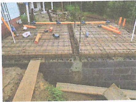
Foto 3: Se preparó la estructura metálica.
