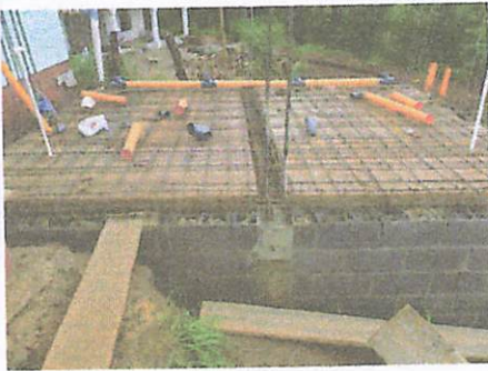
Foto 3: Se preparó la estructura metálica.
