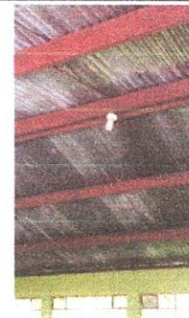
Foto 12: Sustitución de bombillas
