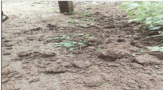
Foto 3: asi quedo enterrado los tubos pvc del agua hacia la cocina
