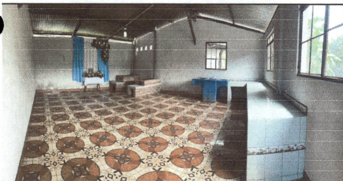
Foto 5: Asi quedo instalado y finalizado el piso ceramico dentro de la cocina.
