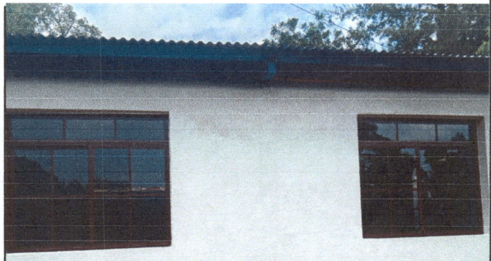
Foto 4: Asi quedo instalada y finalizado las ventanas de la cocina.
