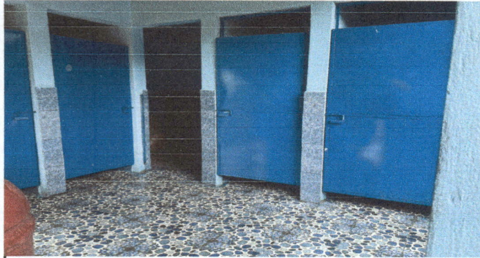
Foto1: Asi quedo los servicios sanitarios con el piso ceramico
