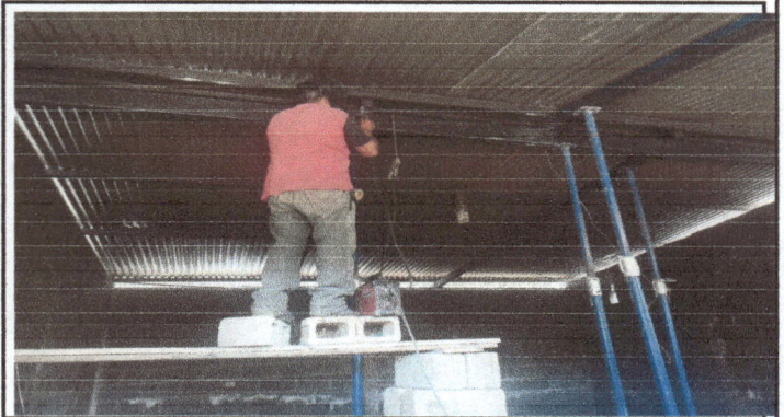
Foto 2: Colocacion de tuvo de 6x2 para sostener el techo de la cocina.
