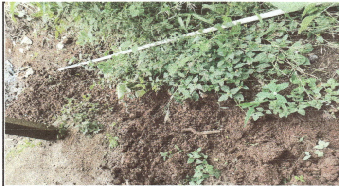
Foto 3: En proceso la instalacion de la tubería Pvc línea principal de agua hacia la cocina.
