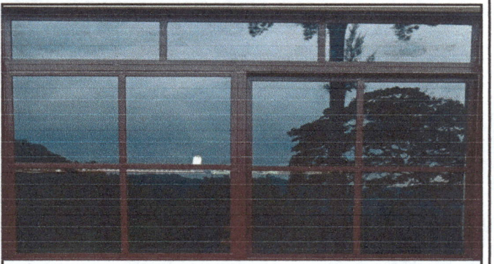
Foto 4: construccion de las ventanas de la cocina
