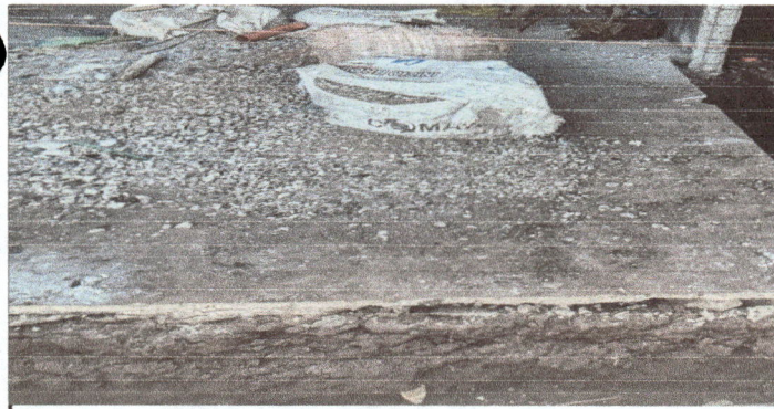
Foto 5: demoliendo el pizo torta para la implementacion de piso ceramico.
