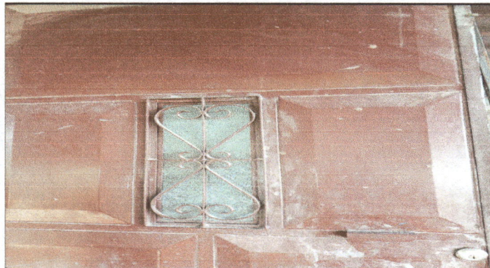
Foto 3: puerta de la cocina en proceso de mantenimiento.
