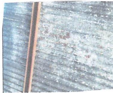
Foto 2: Techado deteriorado
