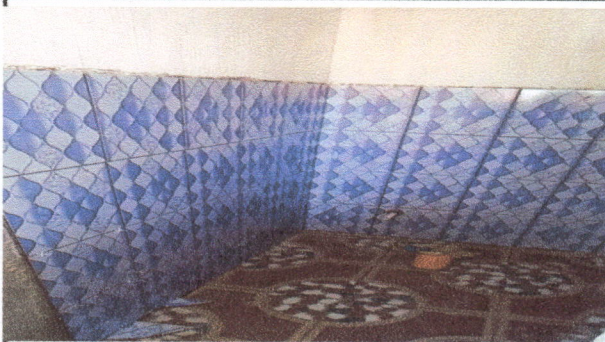
Foto 3: Sanitarios totalmente nuevos con azulejo y piso antideslizante
