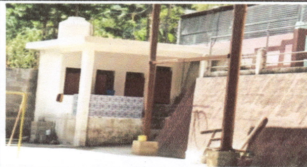
Foto 5: Sanitarios con su pileta renovada y con el tinaco con agua .
