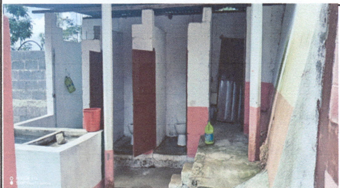
Foto 3: Se ha presupuestado colocar azulejo a las paredes y piso antideslizante a la torta de cemento, se colocaron las puertas que estaban caídas colocandoles hierro para que se puedan sostener a la pila se le impermeabilizaró y se le colocó azulejo también
