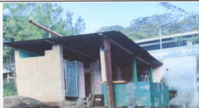
Foto1: Se hará una loza de terraza sobre estos baños, para captar agua y se colocarán sanitarios con su depósito de agua formal
