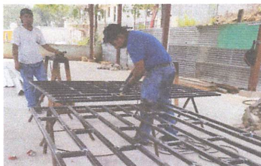
Foto 9 : Baranda de metal área de cocina
