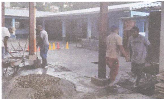
Foto 7: Patio de piso de torta de concreto
