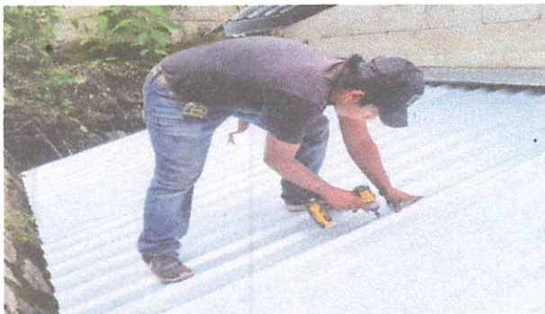
Foto 5: Techo de lámina de sanitarios No. 2
