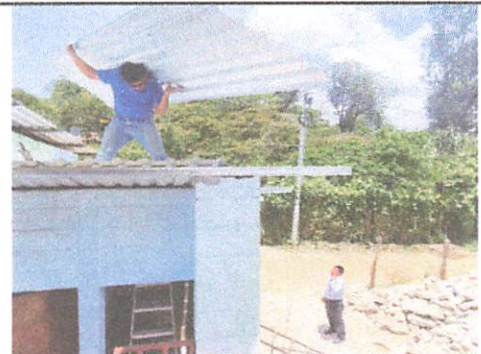
Foto 6: Estructura de metal de sanitarios No. 1
