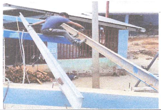
Foto 2: Estructura de metal de aula No. 5
