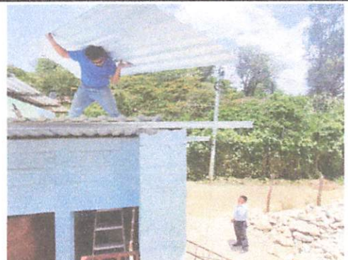
Foto 4: Techo de lámina de sanitario No. 1
