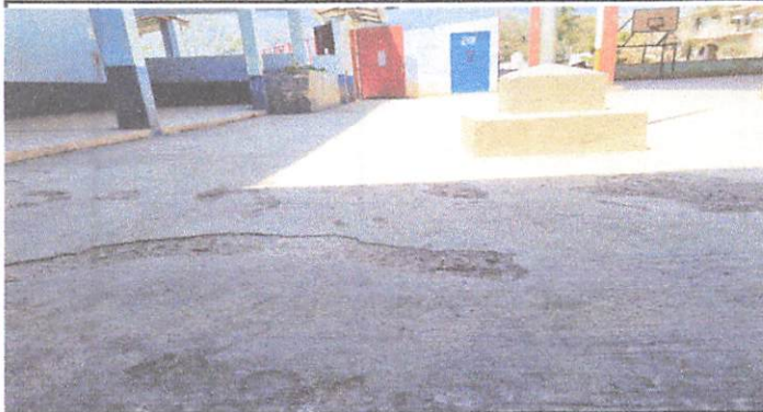
Foto 7: Patio de piso de torta de concreto
