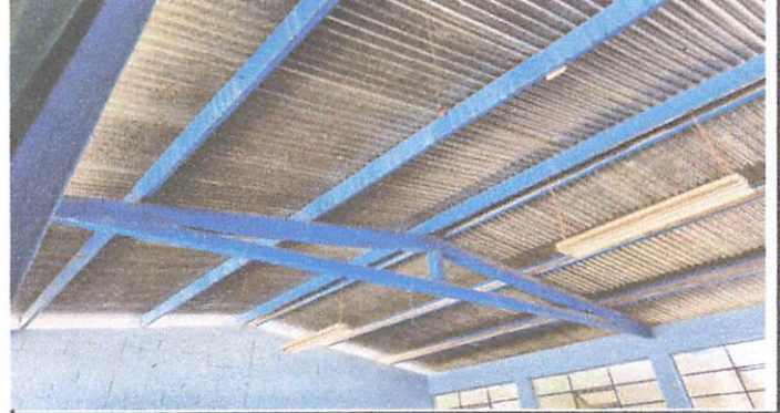
Foto 2: Estructura de metal de aula No. 5
