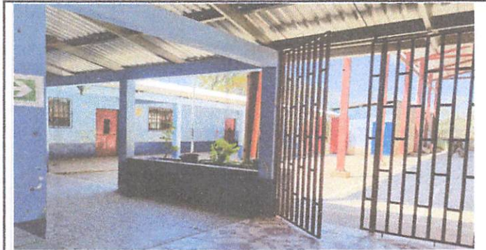
Foto 9 : Baranda de metal área de cocina
