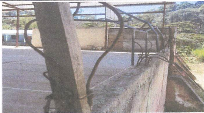
Foto 3: Área a colocar tubos hg y malla galvanizada
