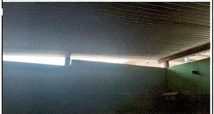
Foto 4: la parte de arriba de la cocina esta muy abierta (entre la pared y techo)
