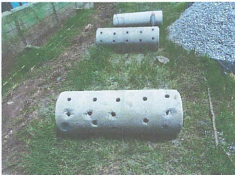
Foto 3: Tubos que se utilizaron en la zanja.
