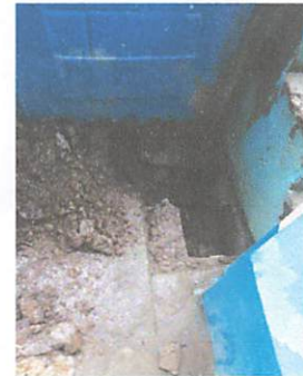
Foto 4: Reparación de bajadas pluviales.
