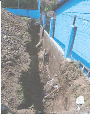
Foto 1: Zanja francesa de 50 mts lineales, 180 mts2
