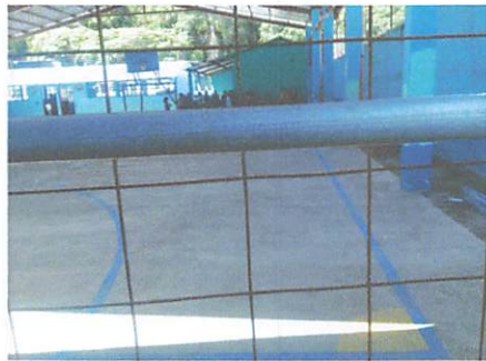
Foto 5: Sustitución de baranda.
