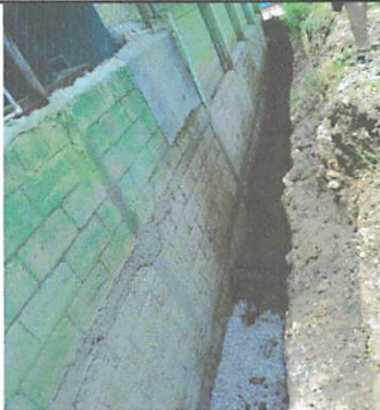
Foto 1: Estado de zanja previo al remozamiento
