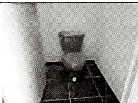
Foto 5: Cambio de baño y colocación de piso
