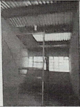
Foto 1: Avances de la construcción
