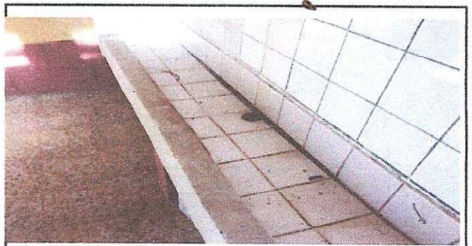
Foto 6: remodelacion de sanitario.
