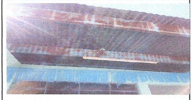
Foto 2: remodelacion de pintura de las costaneras.
