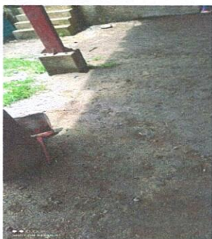
Foto 3: Mantenimiento de pavimento de cancha
