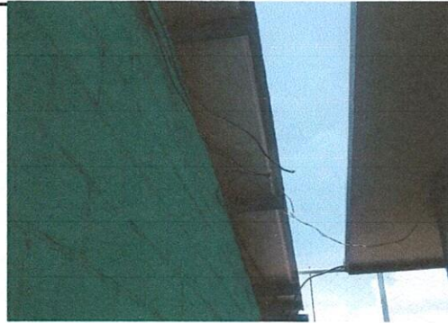
cambio de cableado desde la direccion para el módulo, cisterna y cocina.
