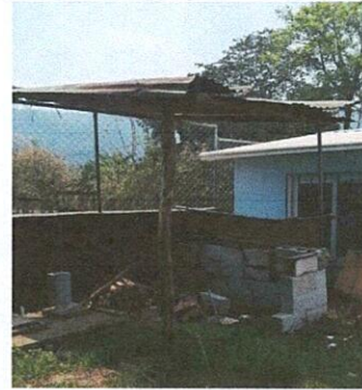
cambio de techo de cocina de leña
