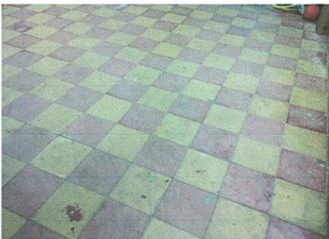
piso del salon de la direccion completamente deteriorado, por lo que se realizará el cambio por piso cerámico.
