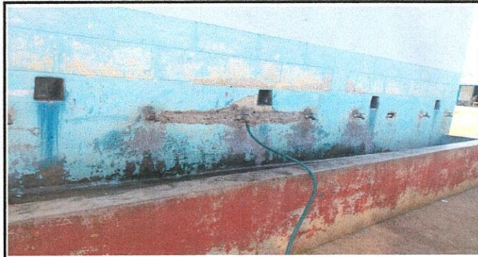
Foto 1 : Remodelacion de chorros para lavamanos.
