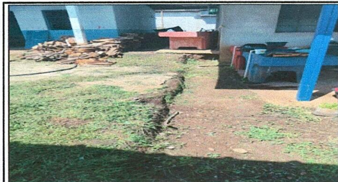
Foto 3 : Construccion de muro de contención en cocina
