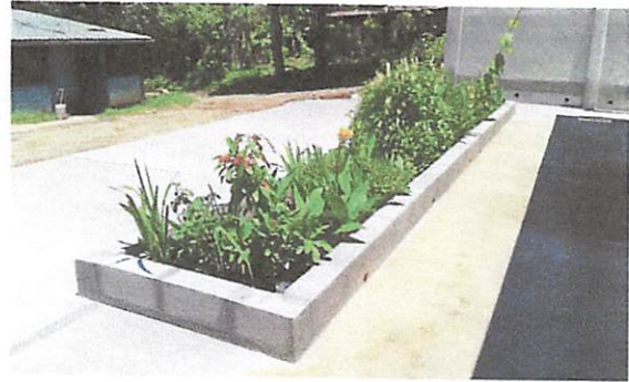
Foto 4: Trabajo terminado de pavimento frente los salones
