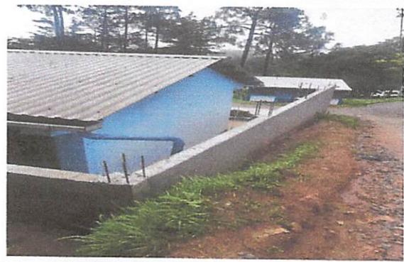
Foto 2: Trabajo terminado muro
