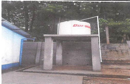
Foto 5: Trabajo terminado base y tinaco
