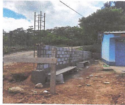
Foto 2: Avance del Muro
