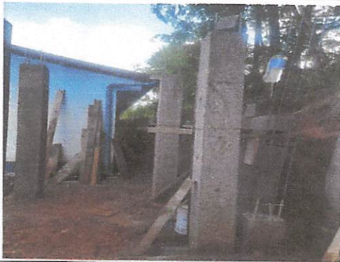
Foto 3: Avance base para tinaco
