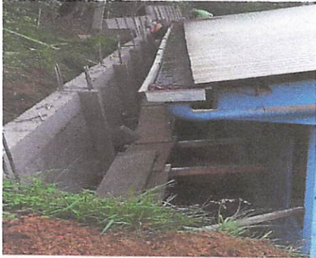
Foto 1: Avance del Muro
