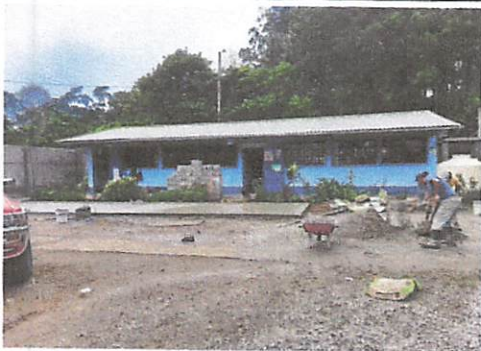
Foto 5: avance de pavimentacion
