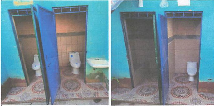
Foto1: SERVICIO SANITARIOS CON NESESIDADES: INSTALACION DE PISO ANTIDESLIZANTE, AZULEJO EN MUROS, CAMBIO DE INHODORO.
