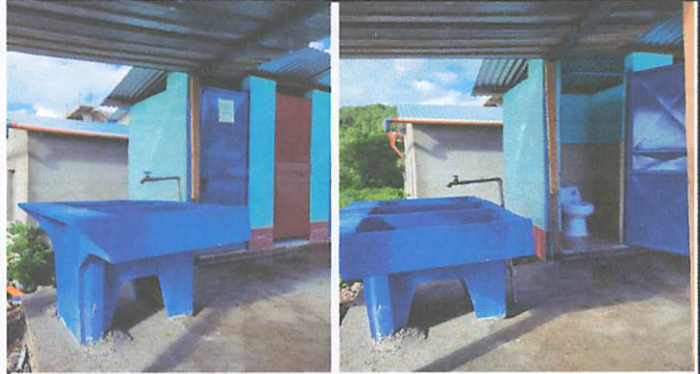
Foto 2: PASILLO ANGOSTO, AMPLIAR PASILLO PARA UNA BUENA CIRCULACION DE LOS NIÑOS EN CUANTO AL USO DEL SERVICIO SANITARIO.
