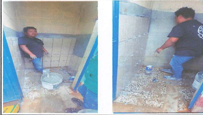
Foto1: SERVICIO SANITARIOS CON NESESIDADES: INSTALACION DE PISO ANTIDESLIZANTE, AZULEJO EN MUROS, CAMBIO DE INHODORO.
