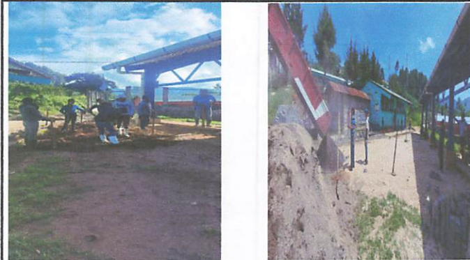
Foto 3: SUSTITUCION DE PATIO EN ADOQUINADO E INSTALACION DE DRENAJE DE AGUA PLUVIAL.
