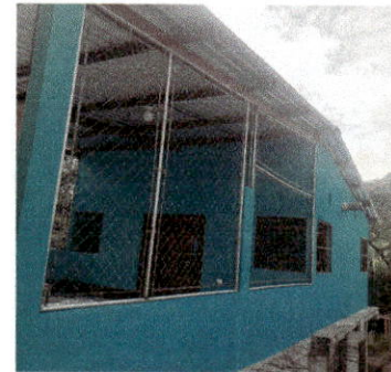
Foto 4: CERNIDO DE PAREDES DE COCINA + PINTURA BASE AGUA
