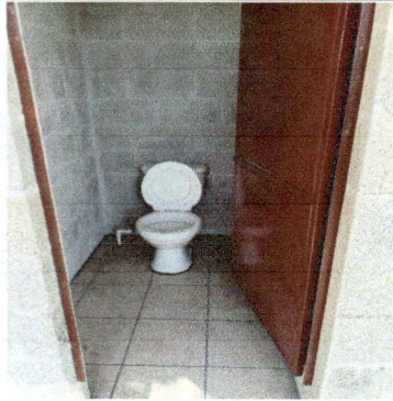
Foto 1: MEJORAMIENTO DE SANITARIO DE LA ESCUELA
