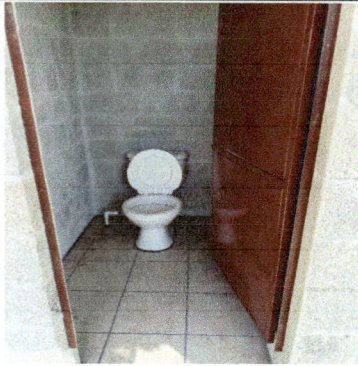
Foto 1: MEJORAMIENTO DE SANITARIO DE LA ESCUELA
