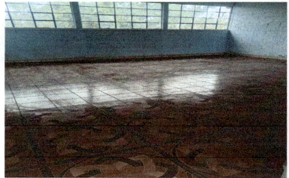
Foto 2: SUSTITUCIÓN DE PISO POR PISO CERÁMICO INTERIOR DE AULAS
