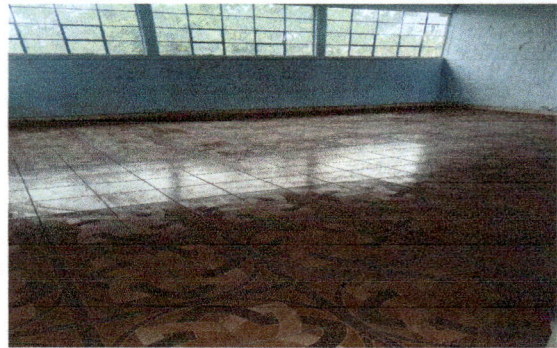
Foto 2: SUSTITUCIÓN DE PISO POR PISO CERÁMICO INTERIOR DE AULAS
