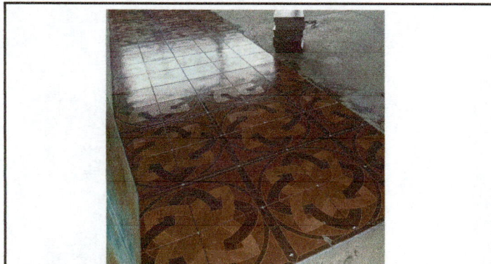
Foto 3: SUSTITUCIÓN DE PISO POR PISO CERAMICO, CORREDOR DE AULAS.
