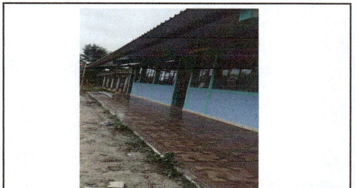
Foto 4: APLICACIÓN DE PINTURA EN PADERES, DE AULAS Y DIRECCIÓN; INTERIORES Y EXTERIORES
