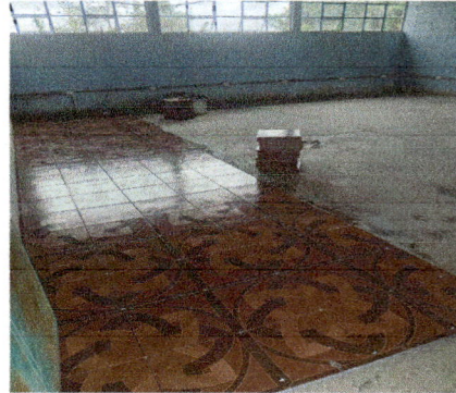
Foto 2: SUSTITUCIÓN DE PISO POR PISO CERÁMICO INTERIOR DE AULAS
