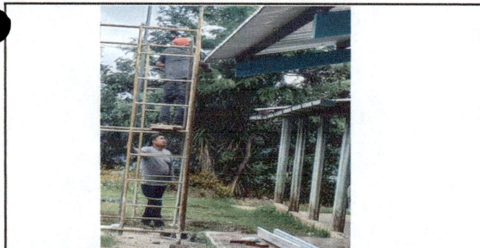
Foto 5: INSTALACION DE CANALES EN CORREDOR DE LAS AULAS
