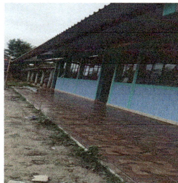
Foto 4: APLICACIÓN DE PINTURA EN PADERES, DE AULAS Y DIRECCIÓN; INTERIORES Y EXTERIORES
