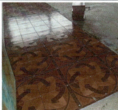
Foto 3: SUSTITUCIÓN DE PISO POR PISO CERAMICO, CORREDOR DE AULAS.
