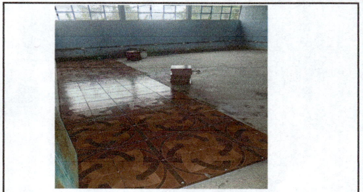
Foto 2: SUSTITUCIÓN DE PISO POR PISO CERÁMICO INTERIOR DE AULAS
