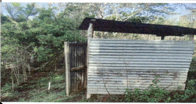
Foto 1: MEJORAMIENTO DE SANITARIO DE LA ESCUELA
