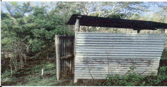
Foto 1: MEJORAMIENTO DE SANITARIO DE LA ESCUELA
