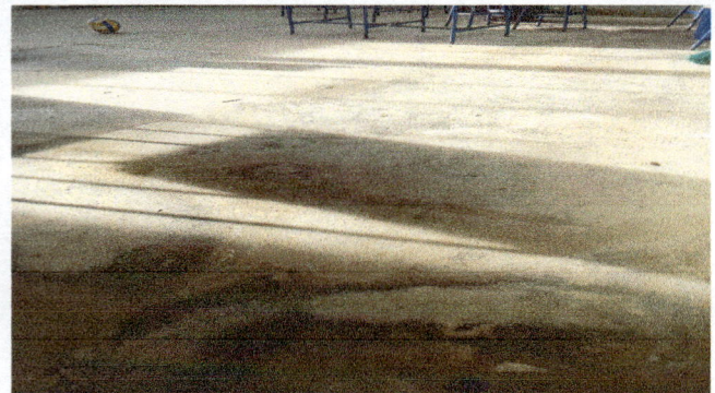
Foto 2: SUSTITUCIÓN DE PISO POR PISO CERÁMICO INTERIOR DE AULAS
