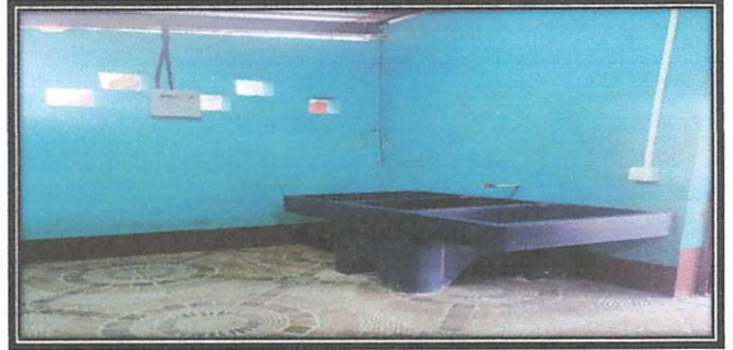
Foto 4: Finalizacion de la instalacion de pila y agua.
