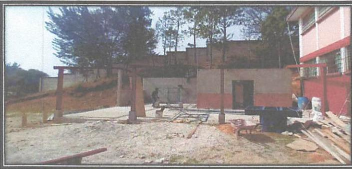
Foto 3: Aquí se da el inicio del nuevo techado y refuerzo de muro por ser un espacio vulnerable de deslave leve durante el invierno.
