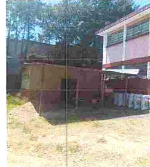
Foto 4: SE NECESITA REPARACION TORTA DE CONCRETO PARA AREA DE SERVICIO.
