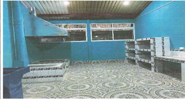
FOTO 10: CULMINACION DE INSTALACION ELECTRICA.
