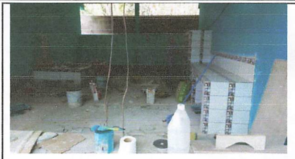
Foto 2: EL PROCESO DE CONSTRUCCION DE REPISA PARA LA COCINA.
