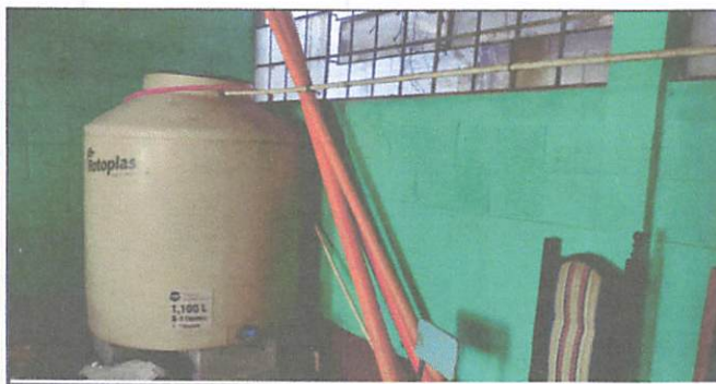
Foto 5: DEPOSITO DE AGUA CON BASE DE BLOCK, SE NECESITA HACER NUEVA BASE Y CAMBIAR DE LUGAR.
