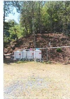
Foto 4: DEPOSITOS EXISTENTES QUE SERVIRAN PARA ALIMENTAR DEPOSITO AEREO DE 5,000 LT CON BOMBA SUMERGIBLE + INSTALACION AUTOMATIZADA CON ELECTRONIVEL.
