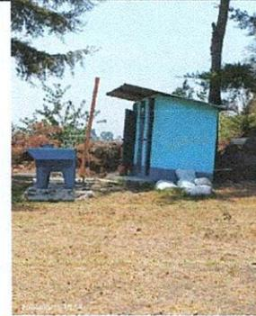
Foto 2: SERVICIO SANITARIO CON NECESIDAD DE AMPLIACION DE TECHO Y AREA DEL MISMO, AMPLIACION DE ESTRUCTURA PORTANTE DE MADERA A METAL.
