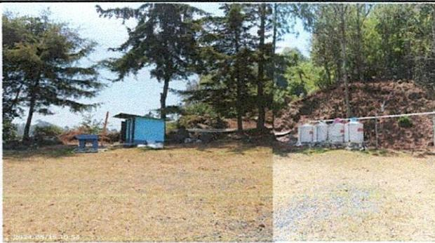
Foto 3: DEPOSITOS EXISTENTE PARA ABASTECER SANITARIOS, POR LA FALTE DE ALTURA NO TIENE PRESION PARA ABASTECER LOS SANITARIOS, ES NECESARIO LA CONSTRUCCION DE UNA ESTRUCTURA PORTANTE PARA DEPOSITO DE 5,000 LT FUNDIDO DE CONCRETO ARMADO PARA EL BUEN FUNCIONAMIENTO DE SANITARIOS
