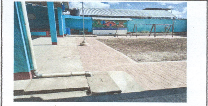
Foto 8: Sustitución de pila.
