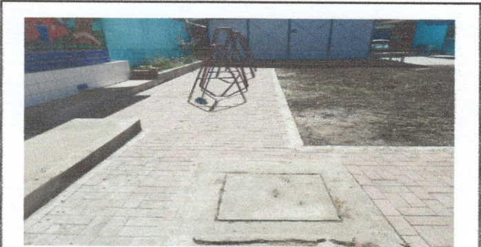
Foto 9: Finalización de adoquinamiento en el patio de juegos de la escuela.
