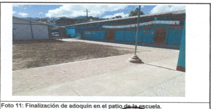
Foto 11: Finalización de adoquín en el patio de la escuela.
