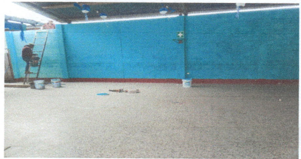
Foto 4: Finalización de impermeabilización de pared exterior.
