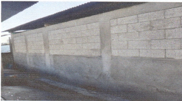
Foto 5: Terminación de cernido gris en pared exterior.
