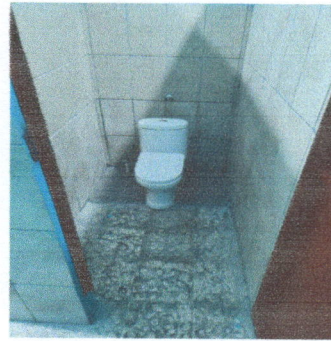
Foto 2: Instalación de 2 sanitarios para varones para población escolar.
