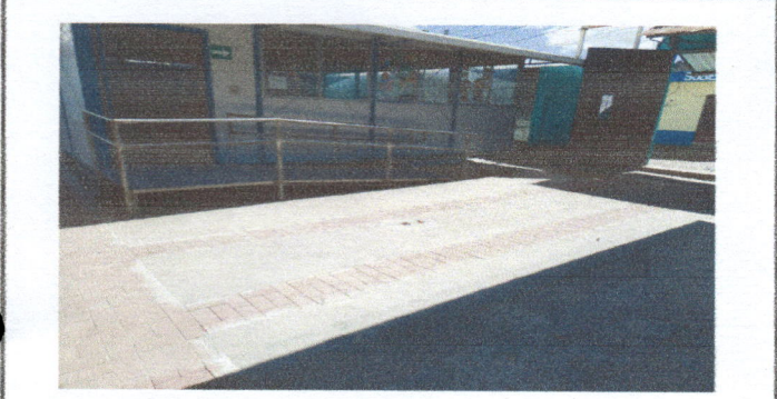
Foto7: Finalización del piso de torta.
