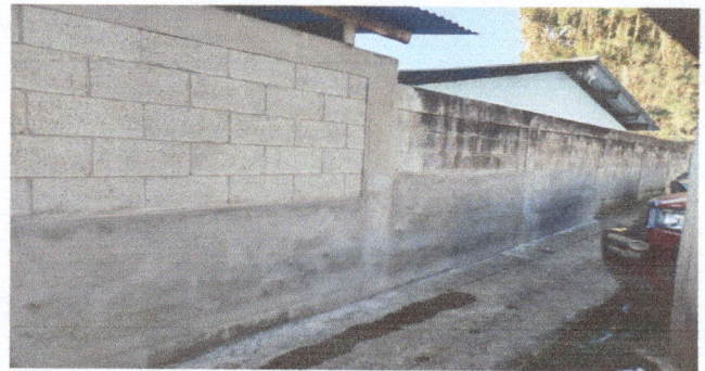
Foto 6: Terminación de cernido gris en pared exterior.
