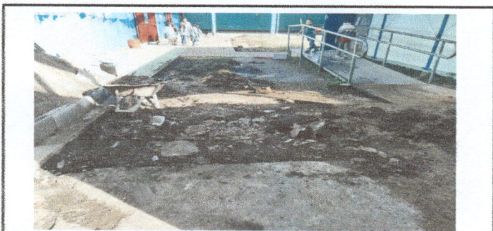
FOTO 11: Deterioro de torta sustituido por adoquin
