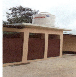
Foto 4: Fundición de una terraza con tinaco puesto
