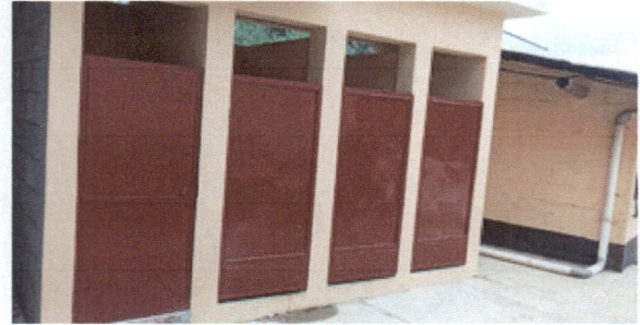
Foto 2: Ampliación de sanitario
