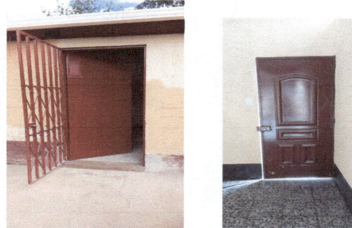
Foto 12: Colocación de puertas y de rejas para la cocina
