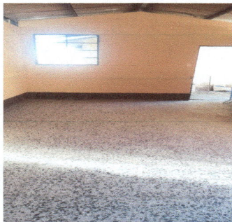
Foto 9: Colocación de piso de granito en la cocina
