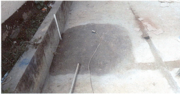
Foto 3: Construcción de fosa séptica terminado
