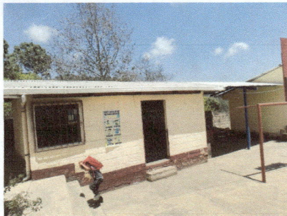
Foto 5: Reparación de cocina
