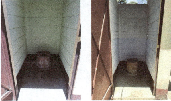
Foto1: Reparación de sanitarios
