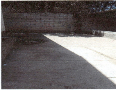
Foto 3: Construcción de fosa séptica
