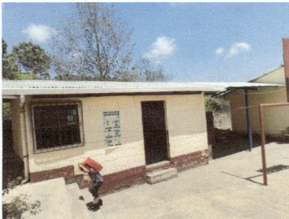
Foto 11: Pintada de la cocina y de los sanitarios
