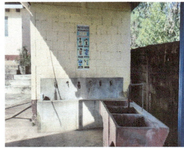
Foto 10: Construcción de nuevos lavamanos
