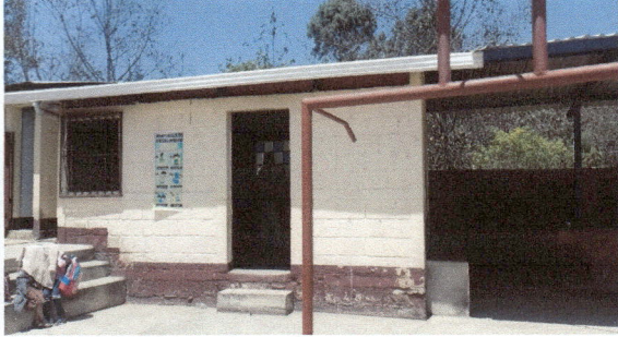
Foto7: Quitar el relleno de la cocina
