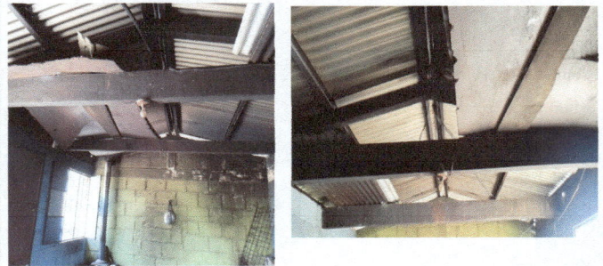
Foto 6: Reparación de estructura de techo
