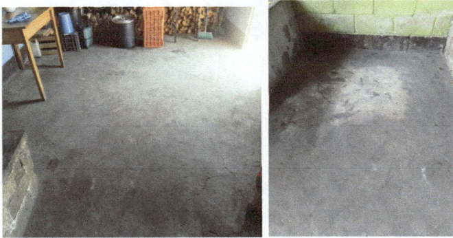
Foto 9: Reparación de piso de la cocina
