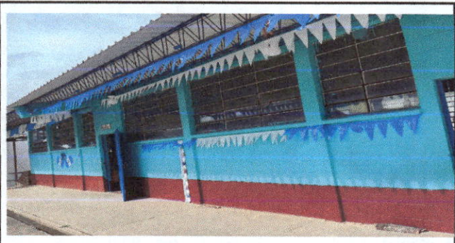
Foto 4: MODULO #1: APLICACION DE PINTURA DE AGUA + ZOCALO DE PINTURA ACEITE.
