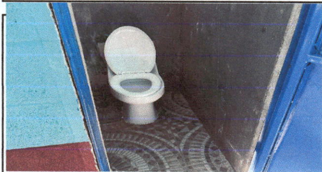
Foto 5: MODULO #4 SUSTITUCIÓN DE SANITARIO TIPO PUSH + ACCESORIOS
