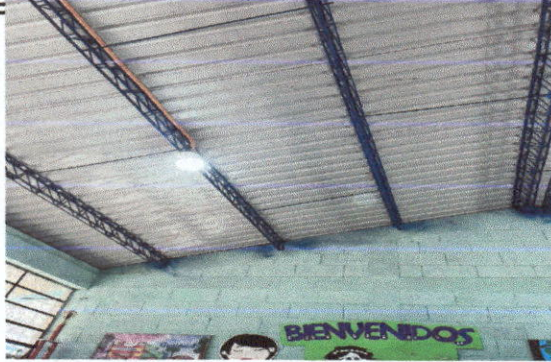
Foto1: MODULO #1: NUEVA INSTALACION USANDO PLAFON Y BOMBILLAS LED.
