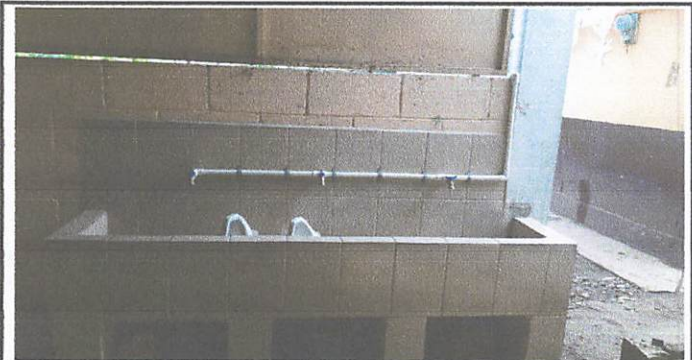
Foto 6: Finalizacion de lavamanos de concreto con tubería PVC y chorros para la distribucion de agua potable.
