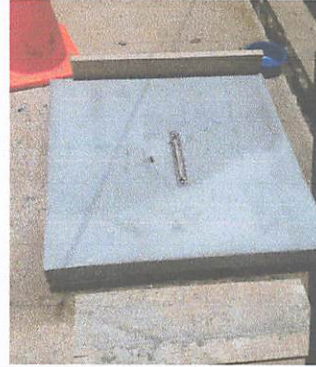
Foto 2: Finalizacion del deposito subteraneo con una medida de 11.5 m, e instalacion de tubería.
