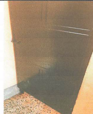
Foto 4: finalizacion de lijada y pintada de puertas para el servicio sanitario.
