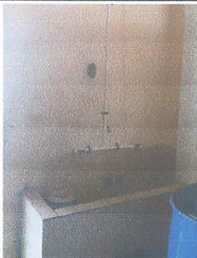
Foto 3: finalizacion de lavamanos de concreto con instalacion de tuvería y chorros para agua potable.
