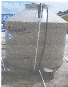
Foto 5: finalizacion de instalacion de deposito y tubería PVC para almacenamiento de agua potable.
