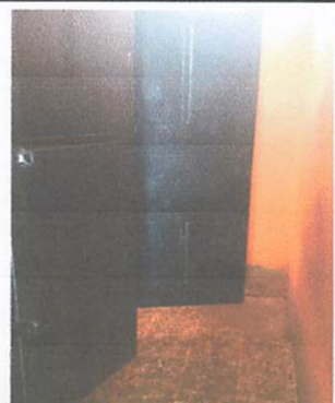
Foto 4: lijada y pintada de puerta para el servicio sanitario.
