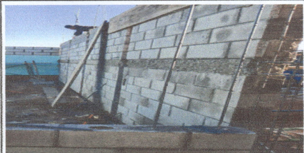
Foto 1: Ampliación de cocina
