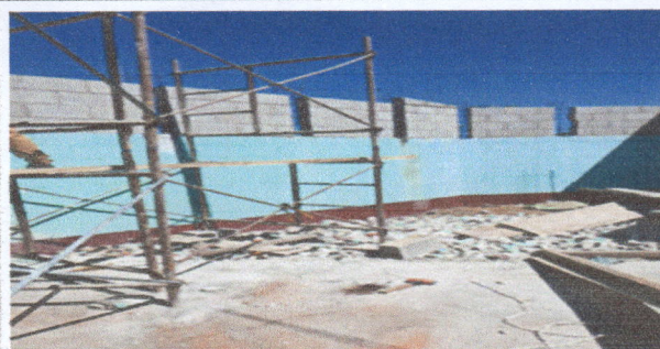
Foto 2: Ampliación de muro existente
