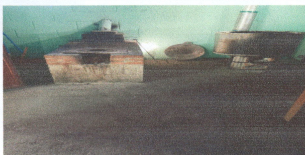
Foto 3: Colocación de piso en la cocina
