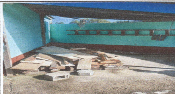
Foto 2: Ampliación de cocina en la parte de atrás
