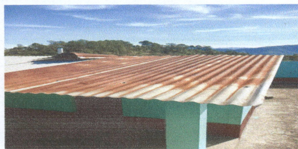
Foto1: Cambio de techo de cocina
