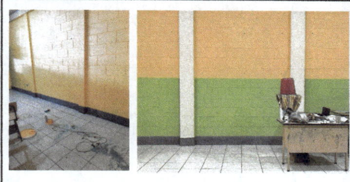
Foto1: Aplicación de pintura impermeabilizante en muros con problemas de humedad de salón de clases
