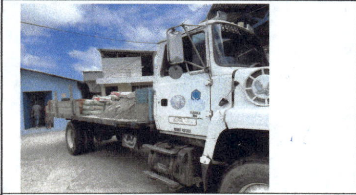
Foto1: Compra y recepción de materiales para inicio de trabajos
