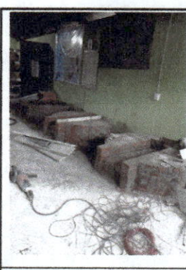
Foto 6: Avance en construcción de poyos de cocina
