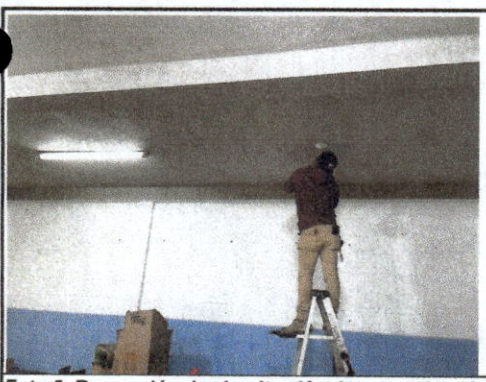
Foto 5: Reparación de circuito eléctrico y sustitución de luminarias en mal estado
