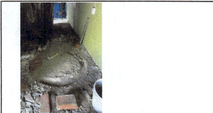
Foto 3: Inicio de obra, construcción de poyos de cocina
