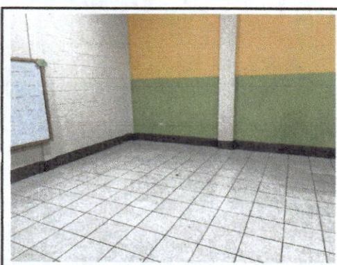
Foto 3: Aplicación de pintura impermeabilizante en muros con problemas de humedad de salón de clases
