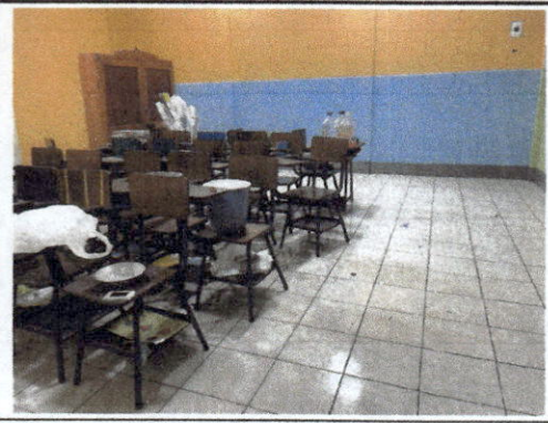
Foto2: Aplicación de pintura impermeabilizante en muros con problemas de humedad de salón de clases
